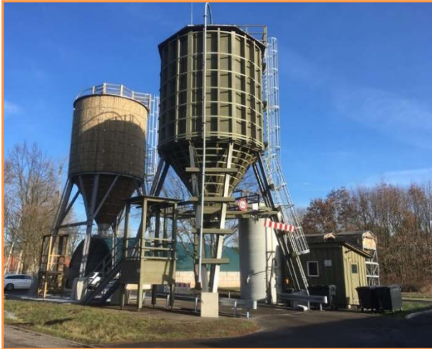
Abbildung 15: Winterdiensttechnik (2 Salz-Silos, 1 Sole-Anlage) am Standort Betriebshof Nedlitz
